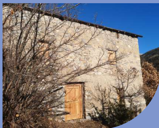
Image du haut : Ancienne bergerie du Bourguet avant travaux / Image du bas : Ancienne bergerie du Bourguet après travaux © GCP.
