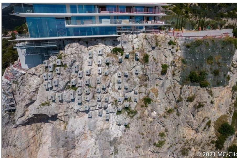
Ensemble des blocs béton consolidant la falaise du site © MC-Clic
