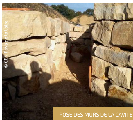
PRÉPARATION DU TERRAIN
