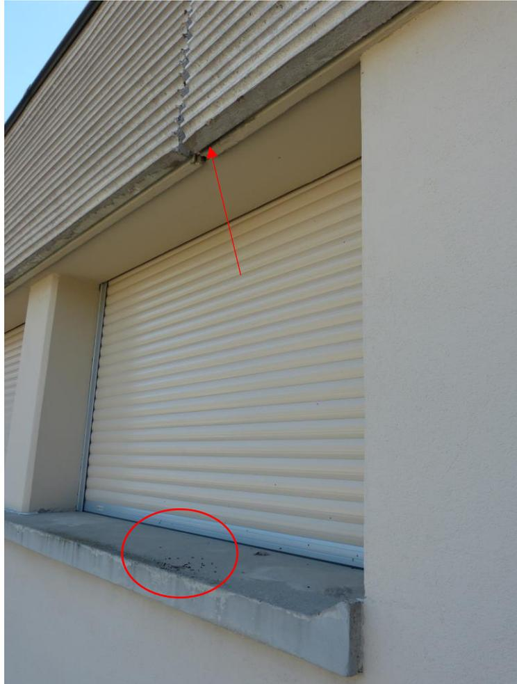
*Photo 24 : Disjointement entre mur et encorbellement*
