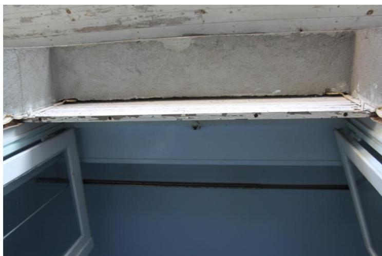
*Photo 16 : Caisson de volet roulant*
