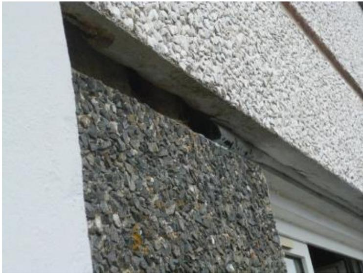
*Photo 18 : Espacement entre les éléments béton*
