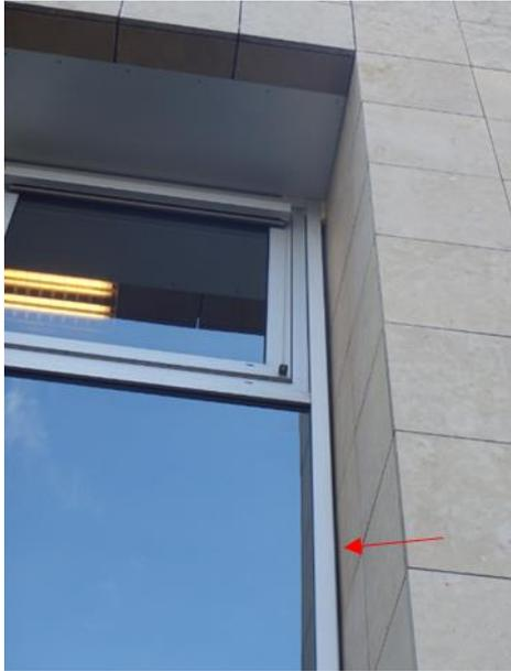
*Photo 20 : Rebord de fenêtre en aluminium*
