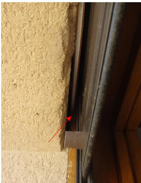
*Photo 19 : Espacement entre volet et mur*
