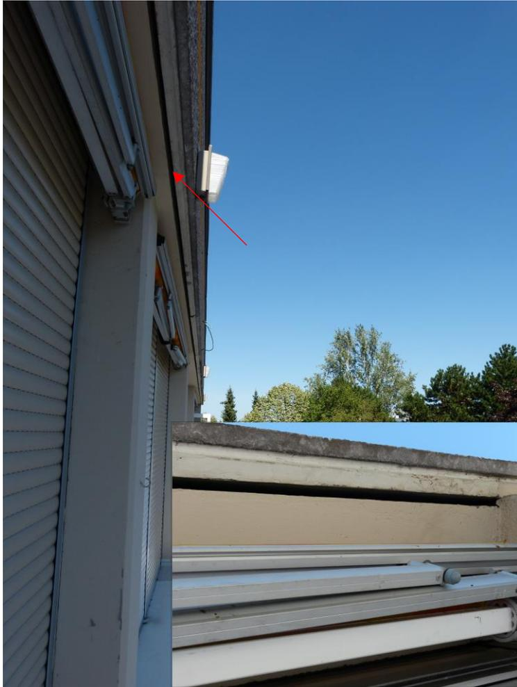
*Photo 22 : Disjointement au-dessus d'une fenêtre*
