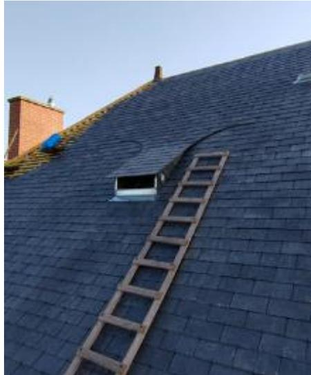
Photo 32 : Création d'une chiroptière au niveau d'une toiture
