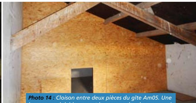
Photo 14 : Cloison entre deux pièces du gîte Am05. Une lucarne modulable permet le passage des chauves-souris et des observateurs d'une pièce à l'autre.
