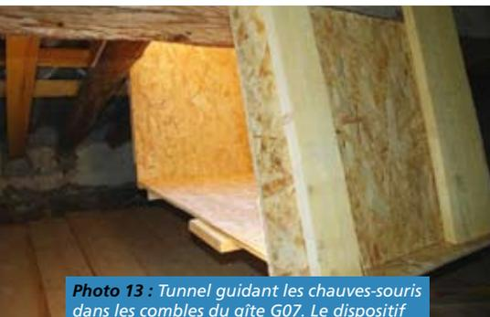
Photo 13 : Tunnel guidant les chauves-souris dans les combles du gîte G07. Le dispositif permet de réduire la luminosité et les courants d'air dans le gîte.
