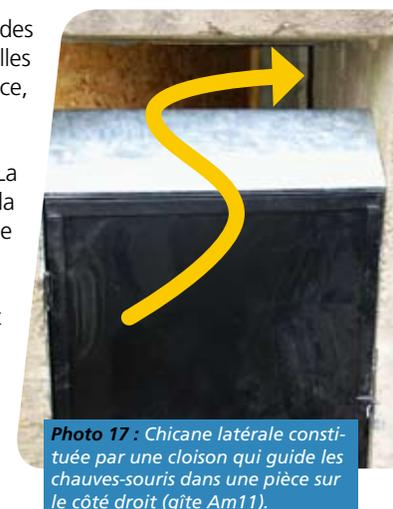
Photo 17 : Chicane latérale constituée par un cloison qui guide les chauves-souris dans une pièce sur le côté droit (gîte Am11).
