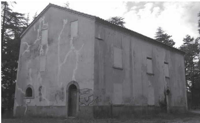
Fig. 3 : façades Est et Nord après travaux. Photo : S. Bourlon
