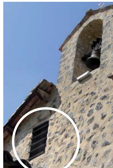
Aménagement d’un accès aux combles d’une chapelle : chiroptière* laissant passer les chauves-souris mais interdisant l’accès aux pigeons. © Delphine Quekenborn
