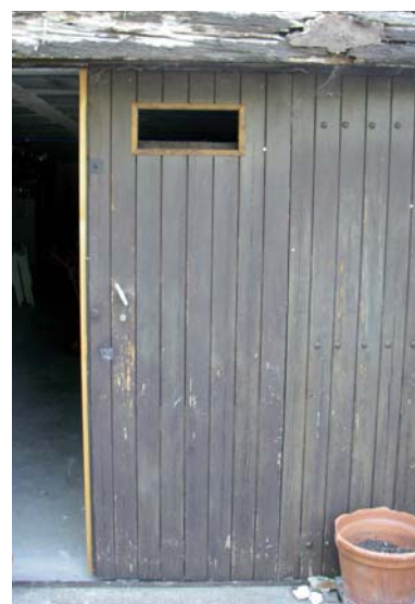
Chiroptière amovible créée dans la porte d’un garage. © Fanny Albalat
