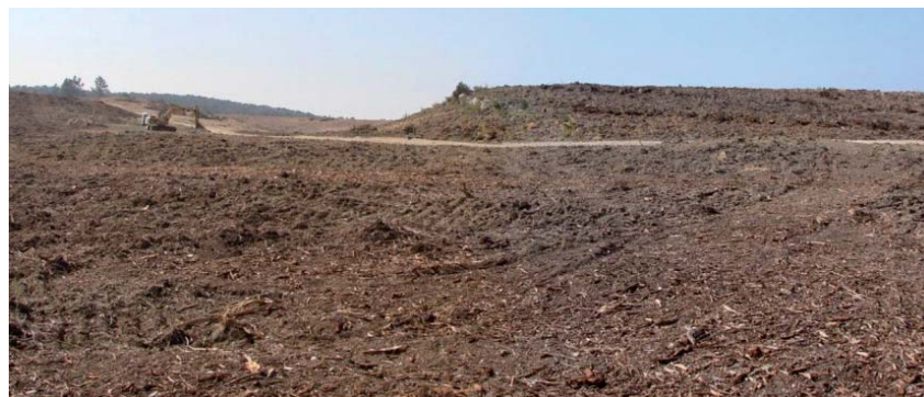
Site d'ITER après la déforestation. © Emmanuel Cosson
