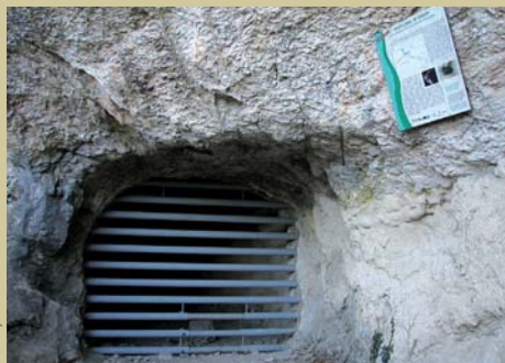
Grille mise en place à l'entrée d'un des tunnels du Verdon (83) pour protéger une colonie d'hibernation de Murin de Capaccini d'importance internationale.
