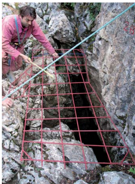
Exemple de fermeture interdisant l'accès aux Chiroptères sur le plateau de Caille (06). © Sylvain Gourmand
