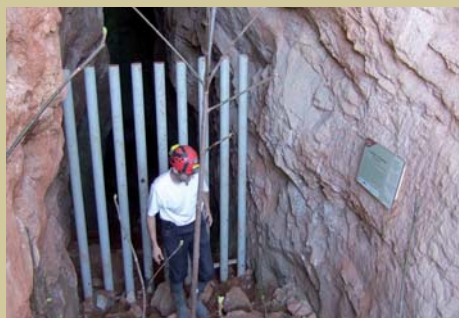
Grille mise en place à l'entrée de la carrière du Fangas (13) pour protéger un gîte de transit de Minioptère de Schreibers .
